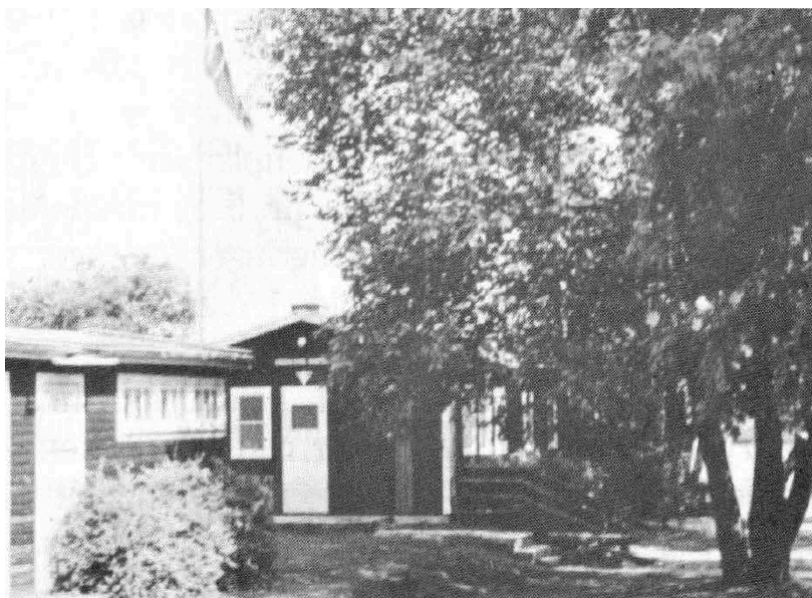
Det nye klubhus blev bygget i 1954.
